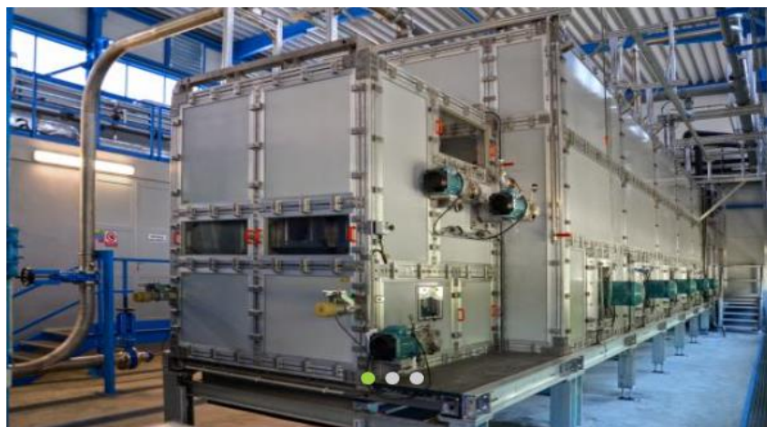
Obr. 2 Nízkoteplotní pásová sušárna ČOV Drahovice (Suez WTS, 2019)
